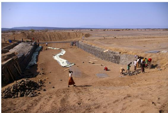
Dès lors, si la mobilisation est maximale, tout est possible. Le stockage des eaux de pluie se fait grâce à des micro-barrages en gabions, le creusement de réservoirs et le traitement de ravines, qui permettra une meilleure infiltration de l'eau et la retenue des sédiments. Formées à la technique de confection des gabions, les populations participent activement aux chantiers.
